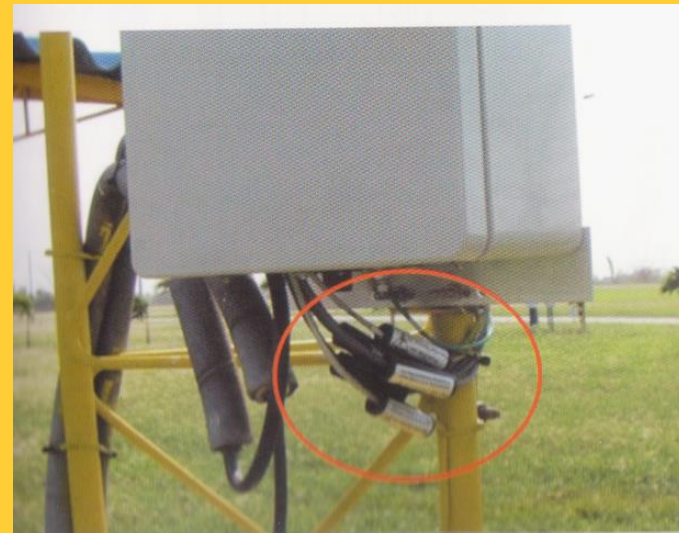
Figura 133. Filtro en modo común
